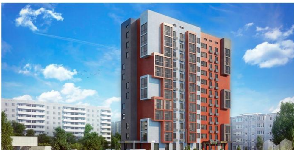
Дом на Сходненской, Фабрициуса ул., д.18, стр. 1 12 000 м 2 общая площадь, готовность 2018 г.
