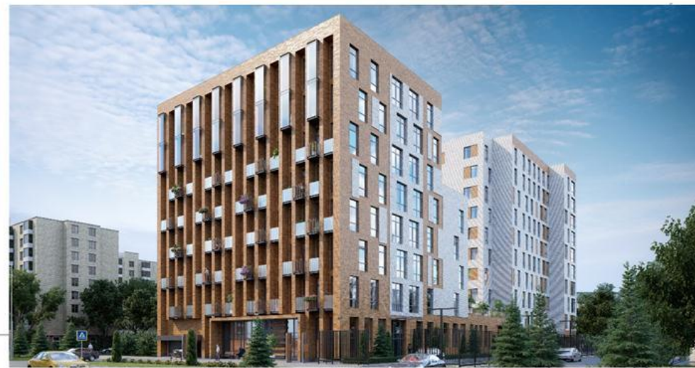
Дом на Усиевича, Усиевича ул., вл. 10Б 14 096 м 2 общая площадь, готовность 2018 г.
